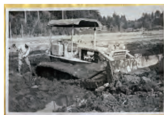
昭和40年頃のほ場整備工事
