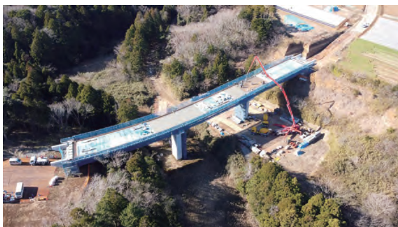
床版コンクリート打設中
