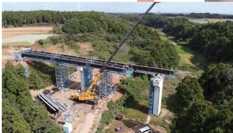
6号橋版桁施工中
