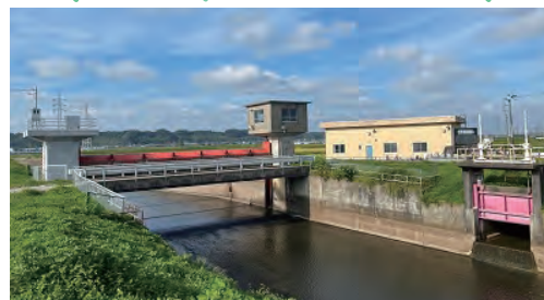
ストマネ事業実施中の富口堰
