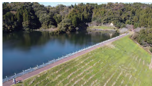
県内最大の農業用ため池 小中池
